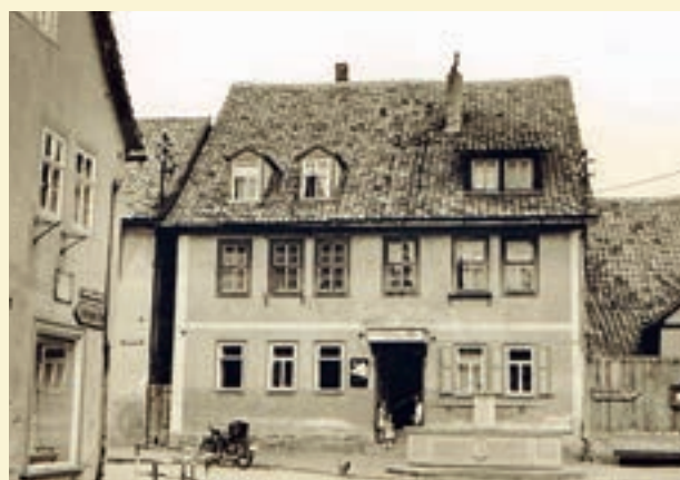
Gaststätte Zum oberen Tor um 1970 (Foto H. Rohrmann)
